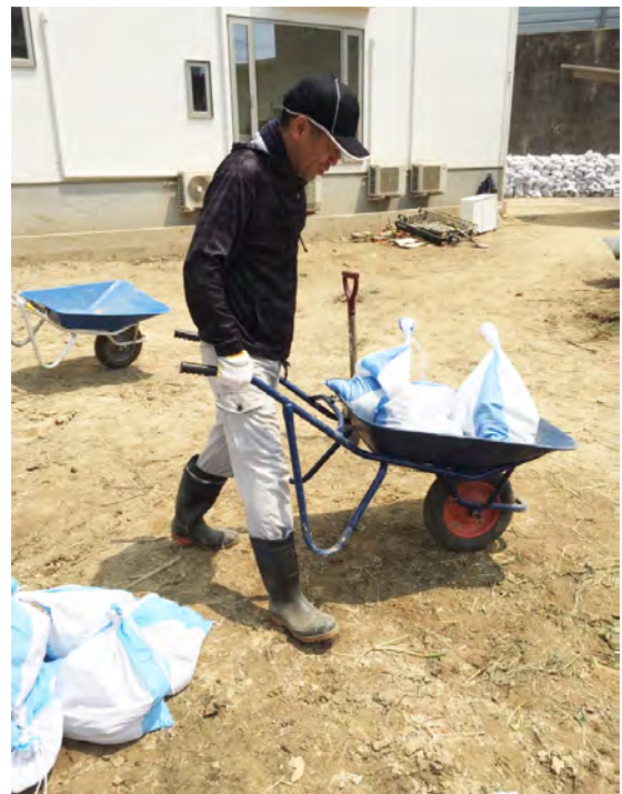
用水路の土砂を除去
